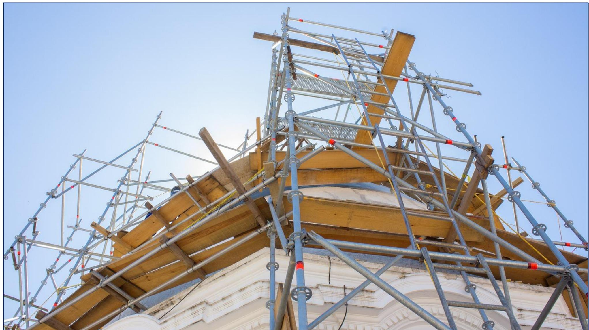
El Sistema de Andamiaje Multidireccional son elementos estructurales que reemplazan los andamios tradicionales, ya que permiten un ensamble fácil y rápido, cuenta con accesorios estructurales multifuncionales que ofrecen los más altos niveles de seguridad a los operarios lo cual facilita su rendimiento, gracias a estos accesorios el desplazamiento en las plataformas es más sencillo y confiable.
